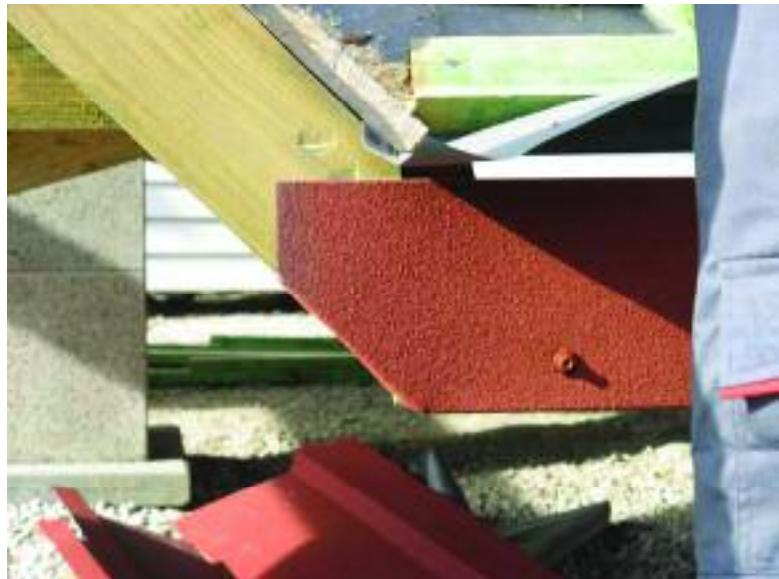
Рис.20. Размещение планки зашивки лобовой доски карниза
