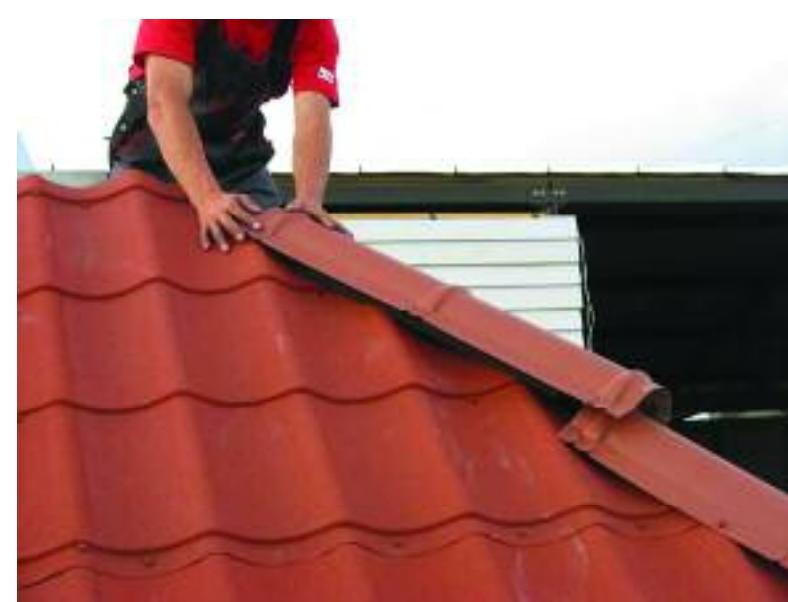
Рис.45. Монтаж смежных планок по длине конька
