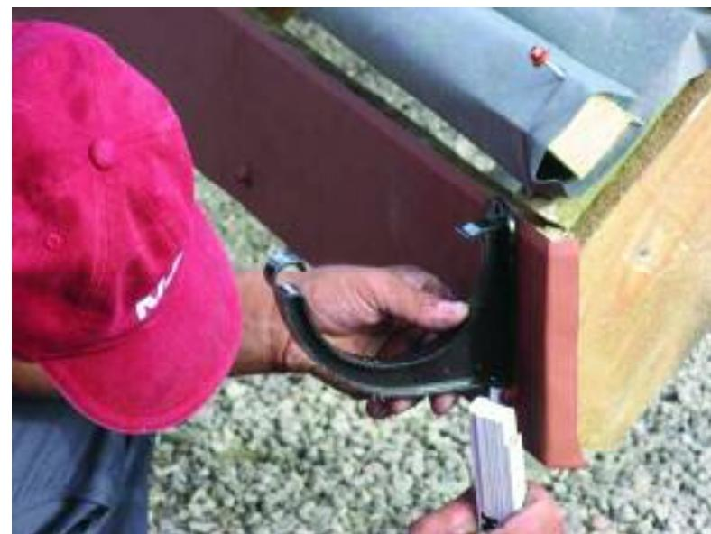
Рис. 50. Установка маяковых (крайних) кронштейнов
