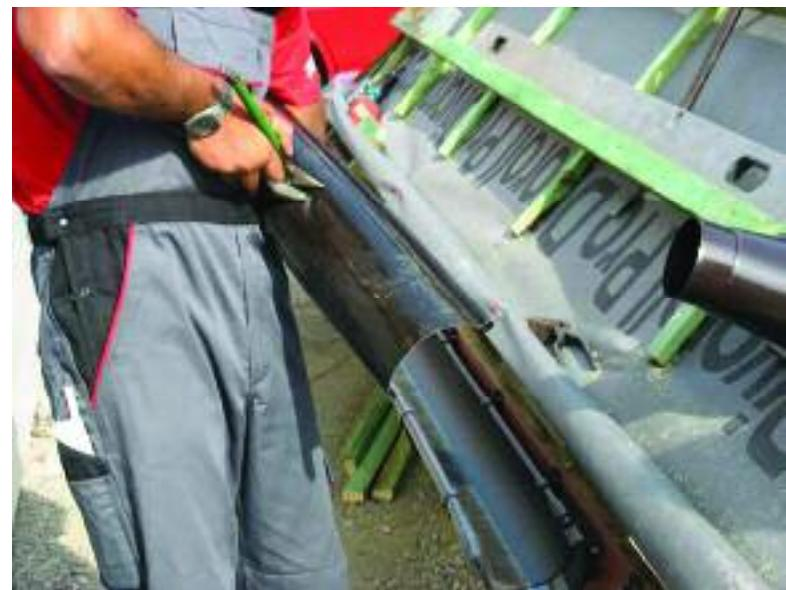
Рис. 54. Вырезание отверстия в желобе для водостока
