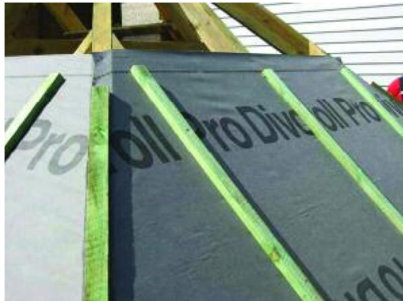
Рис.11. Устройство контрреек
