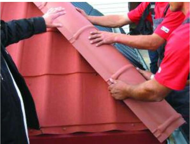
Рис.43. Монтаж планки конька
