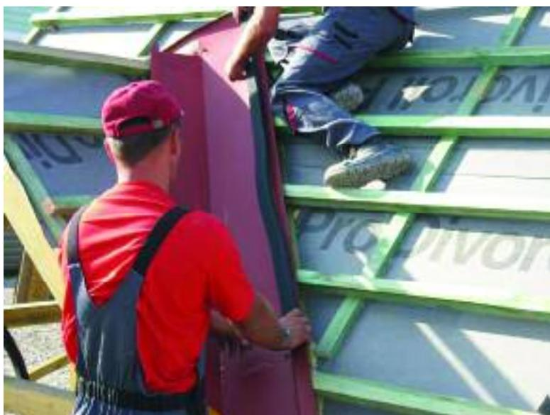
Рис.16. Устройство планки на ендовой
