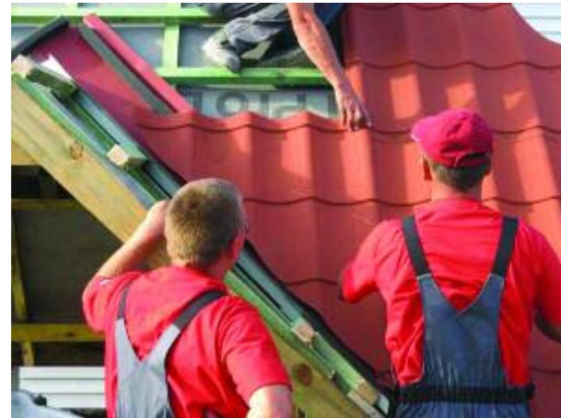
Рис.32. Монтаж третьего листа металлической кровли
