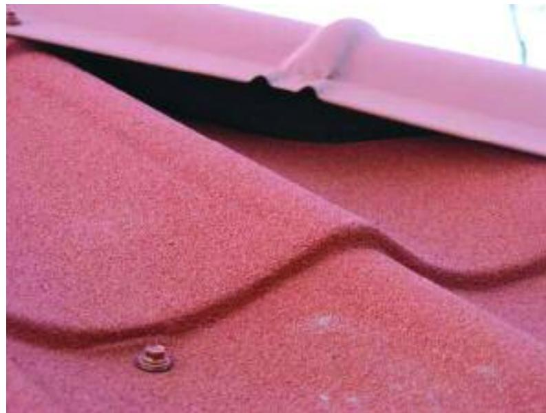
Рис.44. Герметизация подкровельного пространства возле конька
