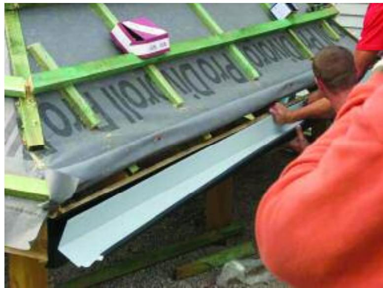
Рис. 57. Размещение планки желоба на лобовой доске
