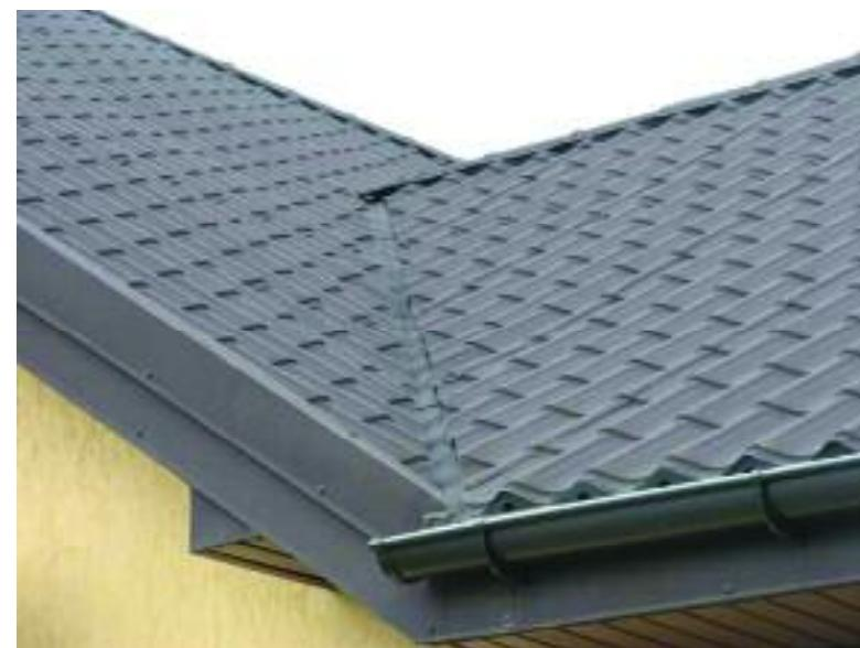
Рис. 75. Отсутствие декоративной накладки на ендове
