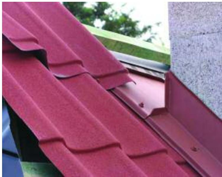
Рис. 70. Напуск металлической черепицы на верхнюю планку фартука
