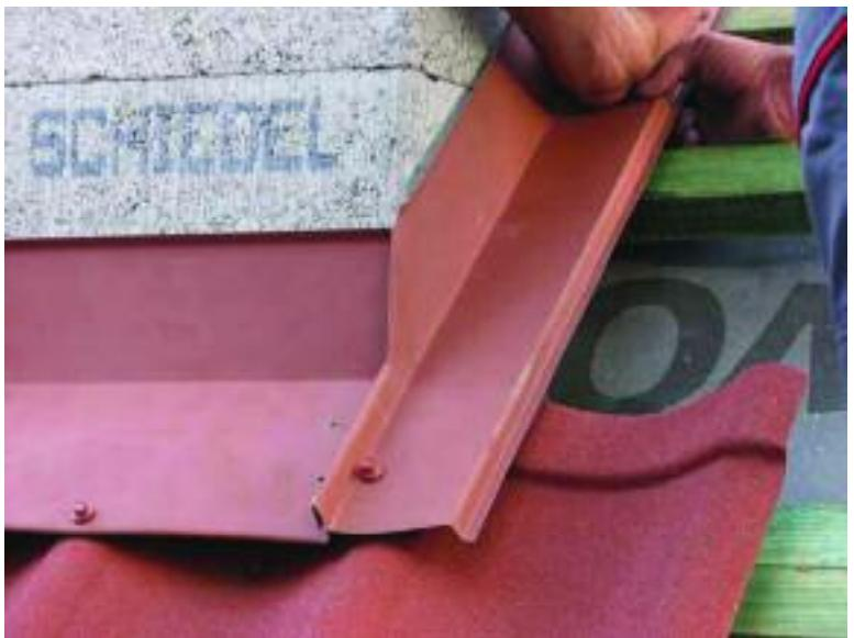
Рис. 66. Определение размеров боковой планки фартука
