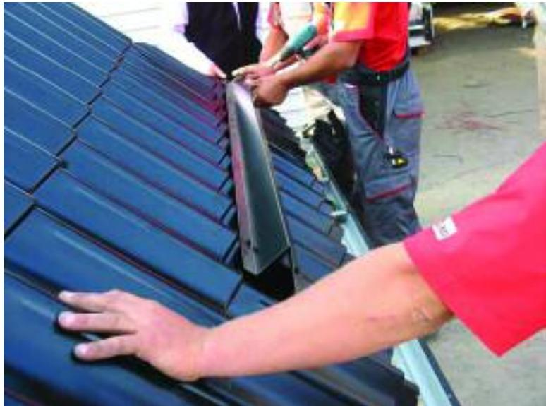
Рис. 60. Расположение планки снегоуловителя на скате
