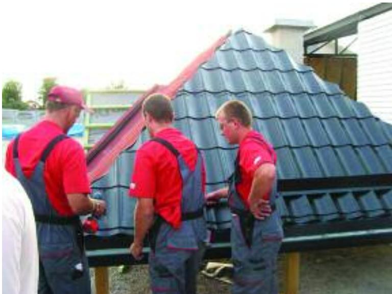
Рис. 62. Расположение планки снегоуловителя вдоль линии карниза ската
