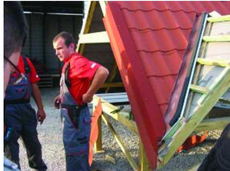
Рис.48. Крепление планки ветрозащиты к ветровой доске
