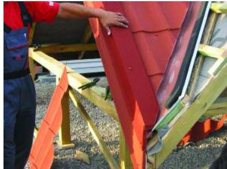
Рис.47. Монтаж планки ветрозащиты
