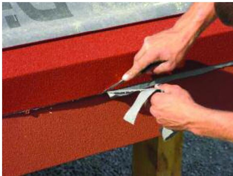
Рис.22. Подрезание краев супердиффузационной мембраны
