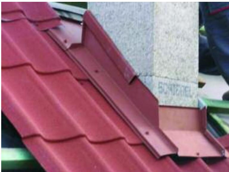
Рис. 71. Устройство защитно-декоративной полосы
