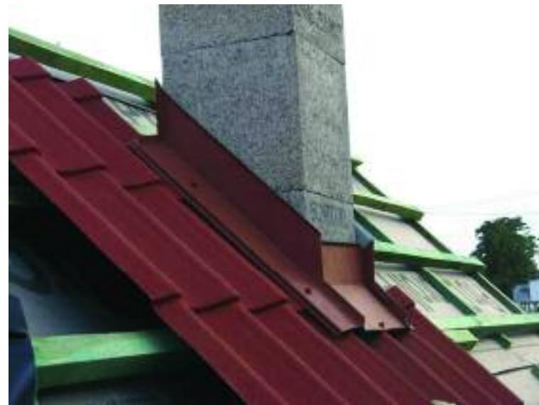
Рис. 68. Расположение боковых и нижней планок фартука
