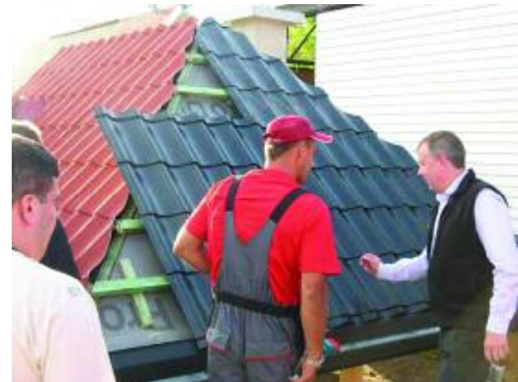
Рис.41. Расположение листов металличерепицы на смежных скатах
