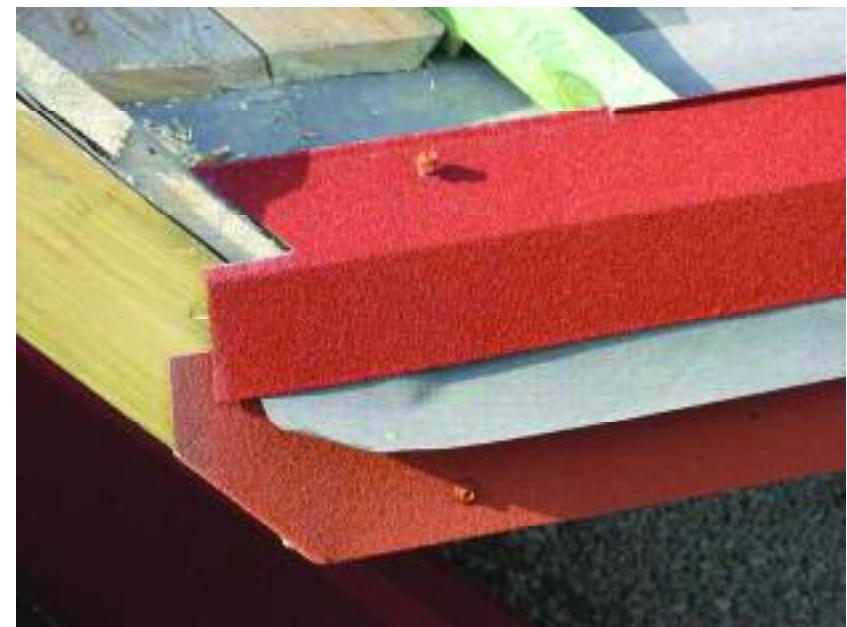
Рис.21. Размещение карнизной планки
