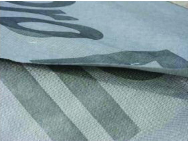
Рис.10. Соединение смежных полотнищ мембранны на стропилах
