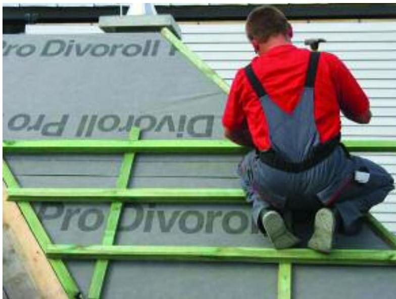
Рис.14. Расположение реек обрешетки на поверхностях скатов
