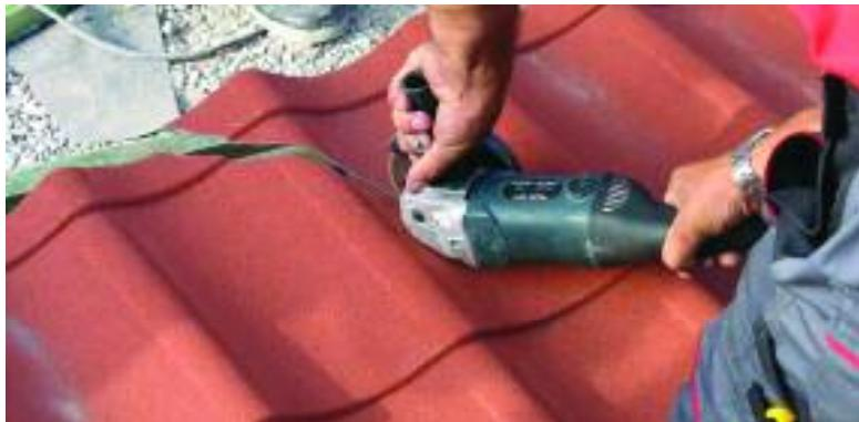
Рис.30. Подрезка второго листа металлической кровли
