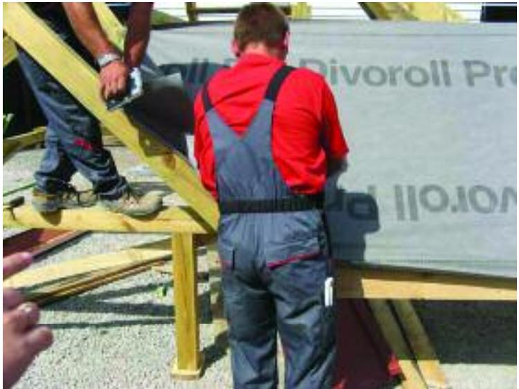
Рис.9. Раскладка полотнищ мембранны на поверхности ската
