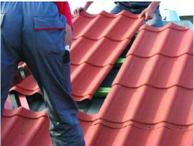
Рис.33. Укладка листа металличерепицы в проектное положение
