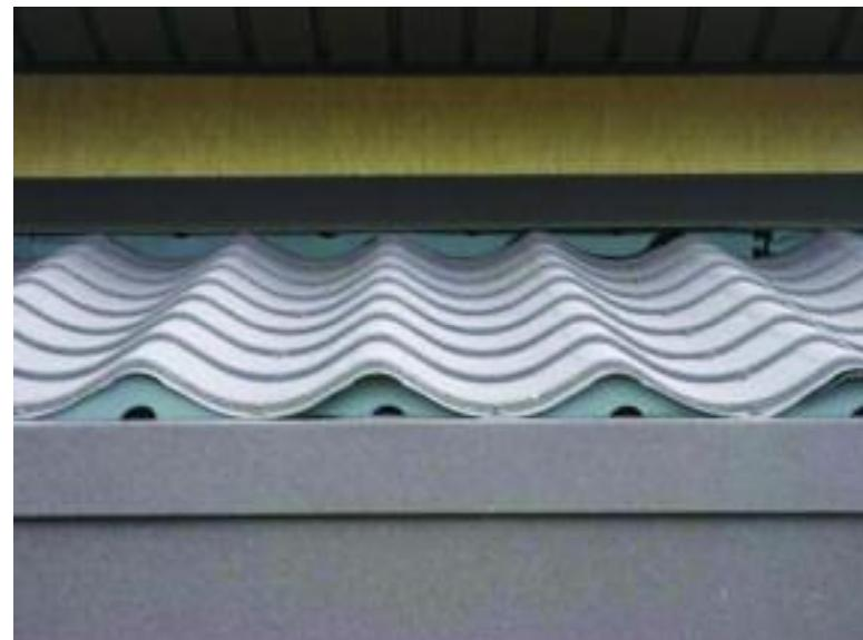
Рис. 74. Расположение уплотнителя на коньке и карнизе ската
