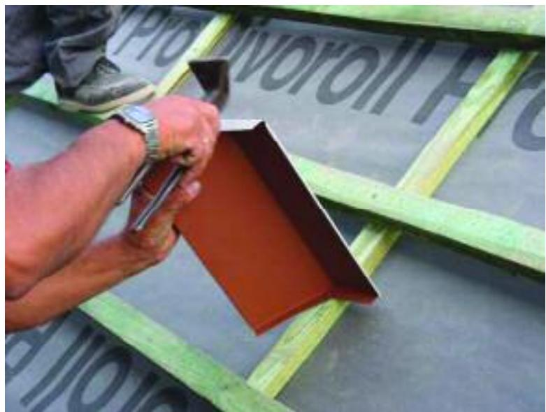
Рис. 64. Изготовление нижней планки фартука
