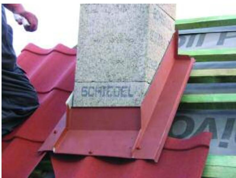
Рис. 67. Монтаж боковых планок фартука
