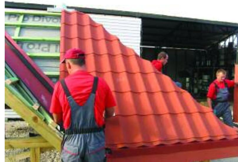
Рис.31. Монтаж второго листа металлической кровли
