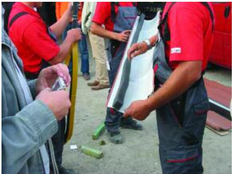
Рис.42. Наклейка универсального уплотнителя
