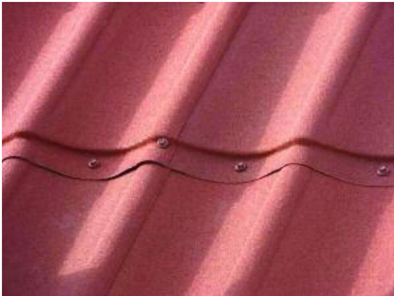
Рис.36. Окончательное крепление
