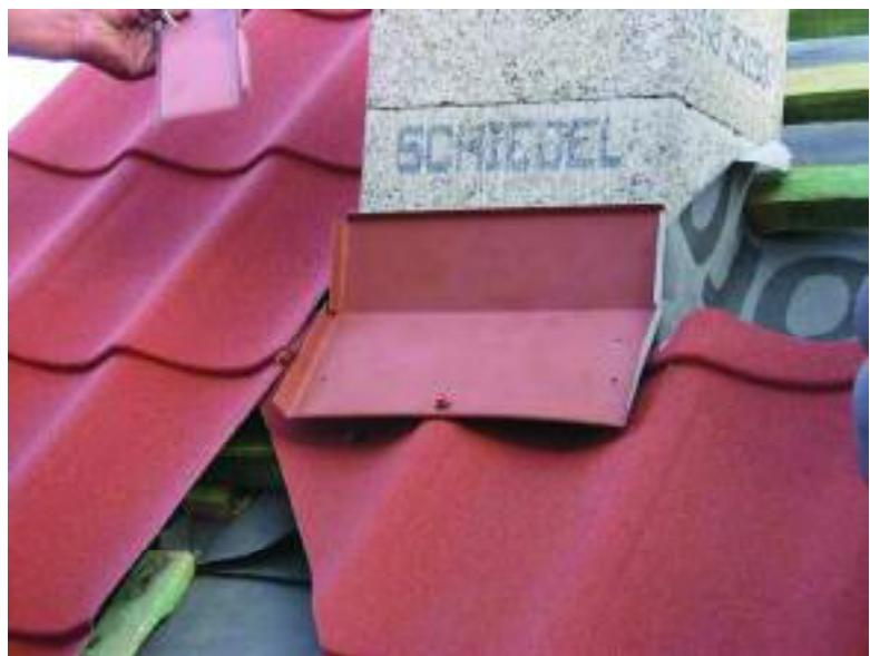
Рис. 65. Монтаж нижней планки фартука
