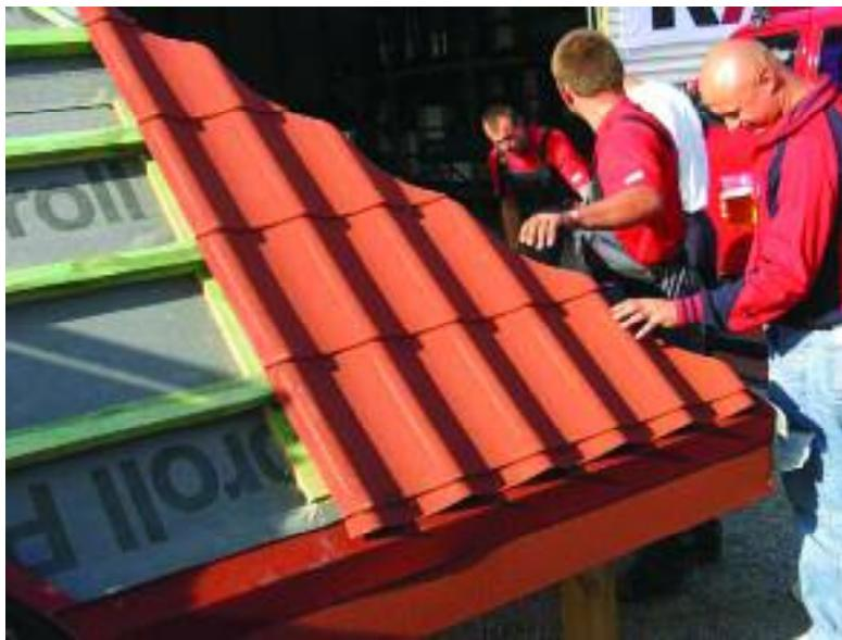
Рис.29. Окончательное закрепление первого листа металлической кровли
