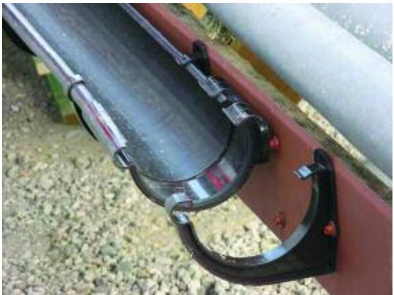
Рис. 52. Установка желобов в кронштейны
