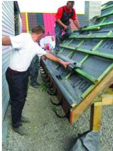
Рис. 51. Установка промежуточных кронштейнов
