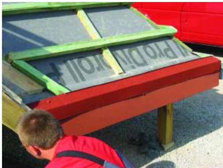
Рис.23. Расположение карнизной планки по длине карниза
